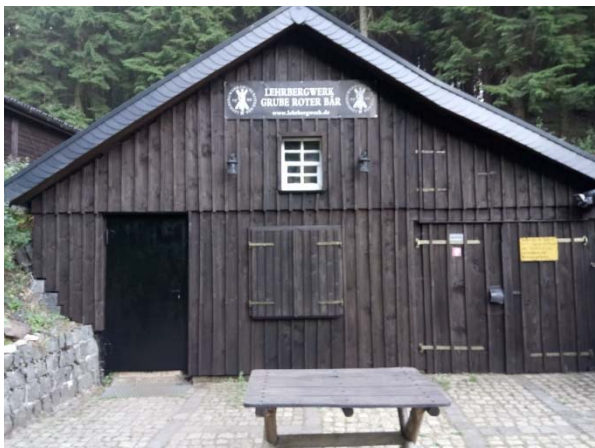
Kauengebäude der Grube nach Ende Streicherarbeiten am 09. August 2018 (Foto M. Bremer)
