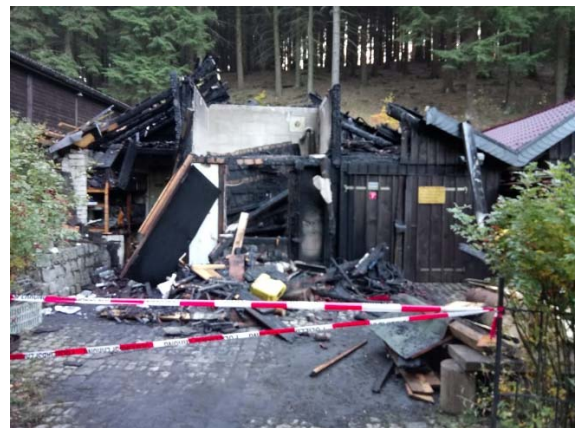
Frontansicht ehemalige Kaue
